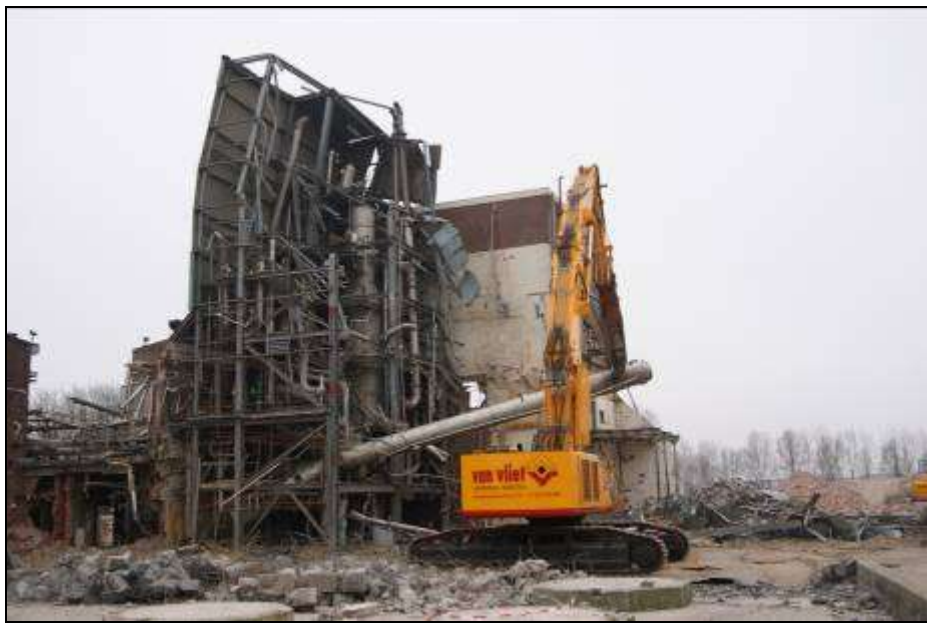
Adım 3) Ekskavatör, kuleyi 25 derece sola çeviriyor
