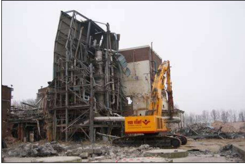
Adım 4) Kuleyi yere doğru itekliyor.
