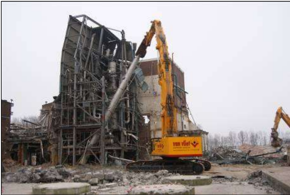
Adım 2) Ekskavatör, kuleyi 25 derece sağa dönderiyor.
