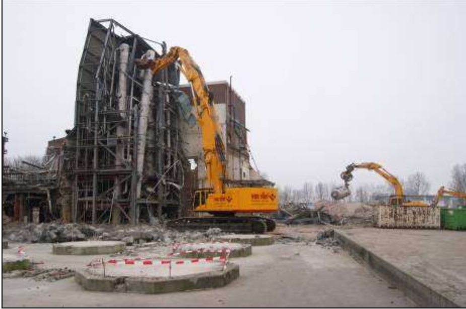
Adım 1 1) Kesme makinası 26 mt yüksekliğindeki kuleye göre ayarlanıyor. (ağırlık yaklaşık 11,5 ton)
